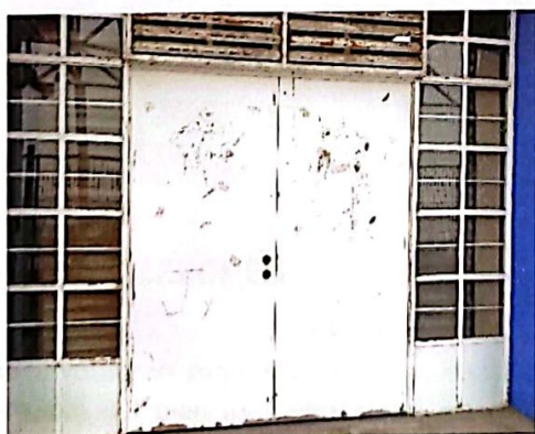
Puertas de acceso de hoja de madera.
