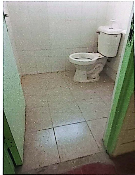
Instalación de revestimiento cerámico en baños damas y varones; cocina (antes palmetas vinílicas flexit en piso), y en muro (estructura de muros albañilería de bloques de hormigón pintado a la vista).
