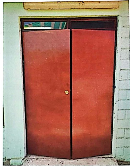
Por acceso lateral a sede, se cambió puerta doble hoja (barnizada) con cerradura y pestillo pasador alargado para seguridad.
