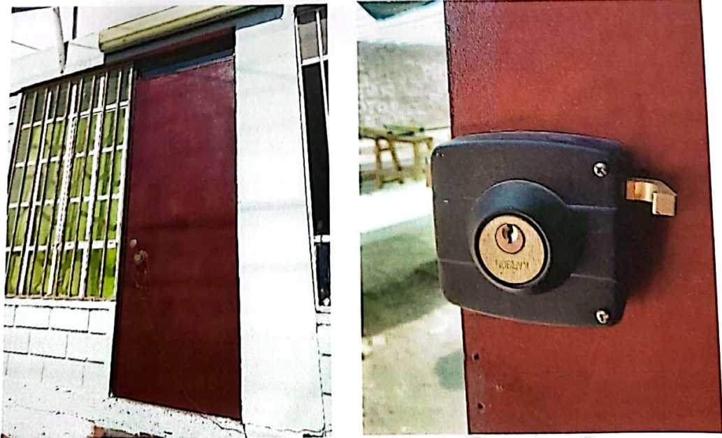
Acceso principal, recibió cambio de puerta barnizada con cerradura cerrojo doble.
