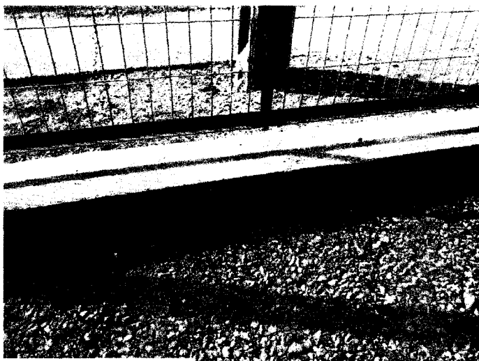
Instalación Malla ACMA
