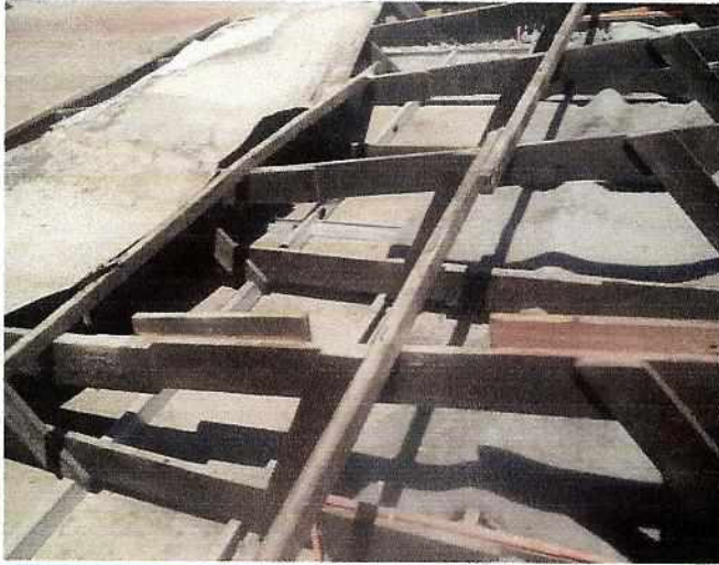
Fotos proceso de trabajo mejoramiento de techumbre n-3
