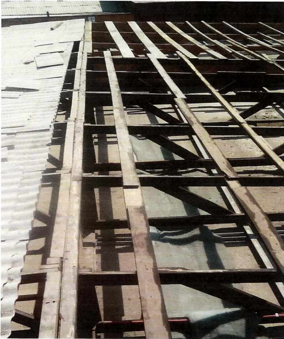
Fotos proceso de trabajo mejoramiento de techumbre n-4
