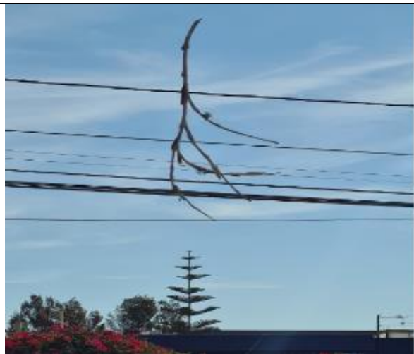
Fotografía N° 73. Calle 18 de Septiembre.
