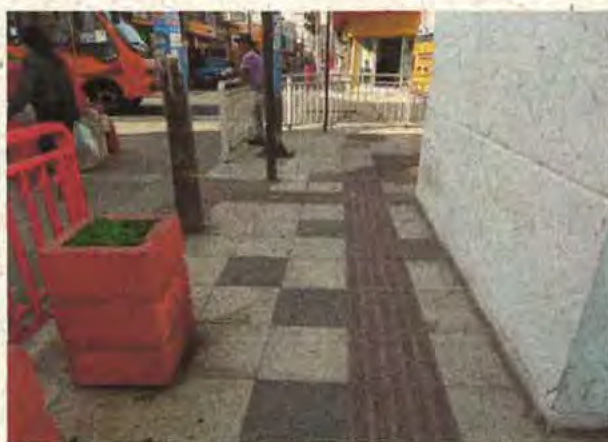
Fotografía N° 9, ubicación pavimento de alerta y guía de avance seguro, calle Cristóbal Colón esquina Maipú, acera oriente, 9 de agosto de 2017.
