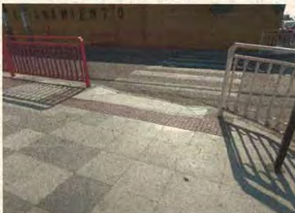
Fotografía N° 7, ubicación pavimento de alerta en rampa calle Cristóbal Colón esquina Chacabuco, acera oriente, 9 de agosto de 2017.
