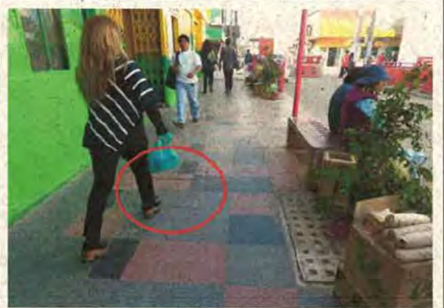
Fotografía N° 6, calle Cristóbal Colón, entre Maipú y 18 de septiembre, acera poniente, 9 de agosto de 2017.
