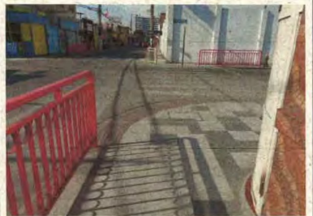
Fotografía N° 8, ubicación pavimento de alerta en encuentro vereda y calzada, calle Cristóbal Colón esquina Manuel Rodríguez, acera oriente, 9 de agosto de 2017.
