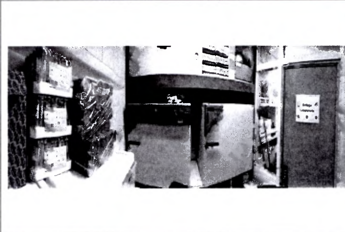
Fotografía N° 1: Interior de la Bodega
