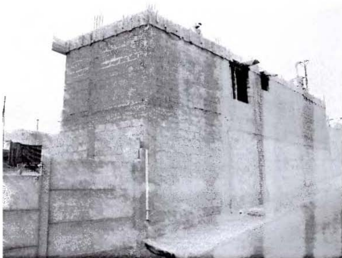
Fotografías 1 (8 de octubre de 2012) Ejecución de obra gruesa de 1º y 2º Nivel
