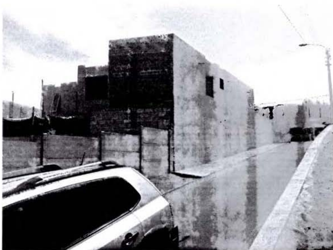
Fotografías 2 (10 de diciembre de 2012) Termino de obra gruesa. se advierten trabajos de terminación exterior.
